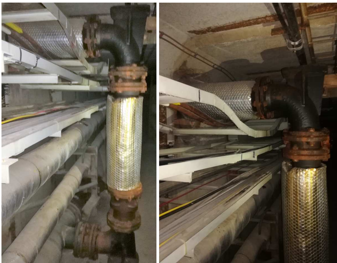
Obr.č. 1 – napojení stávajícího překládaného potrubí (LITINA DN150) na stávající areálový řad v kolektoru.
